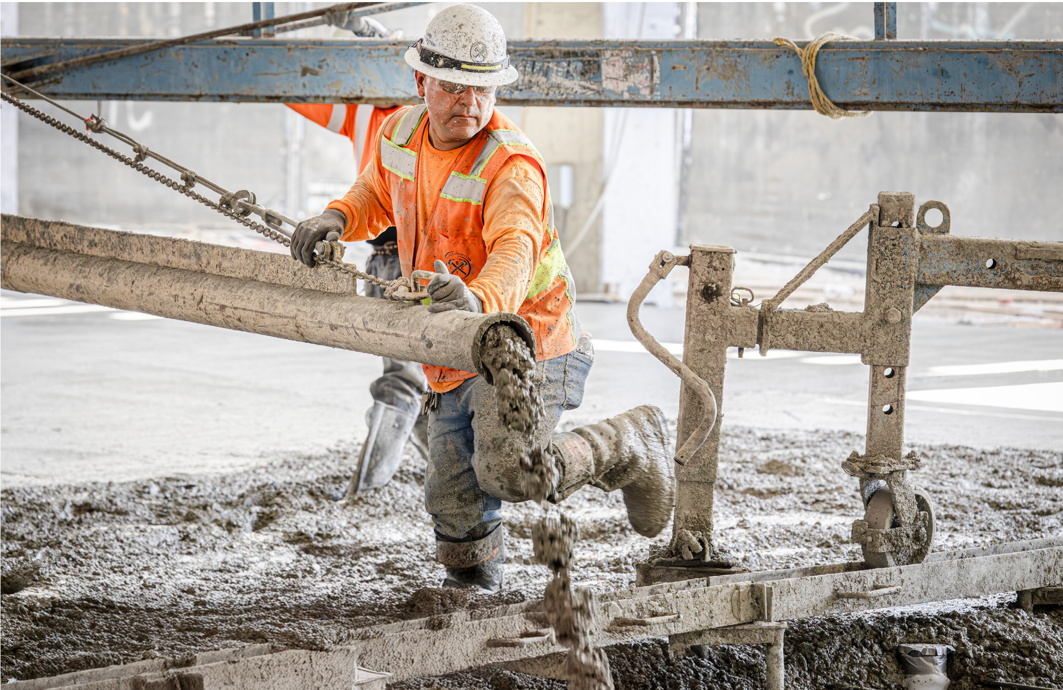
Laborers Local 1184 pouring concrete.
